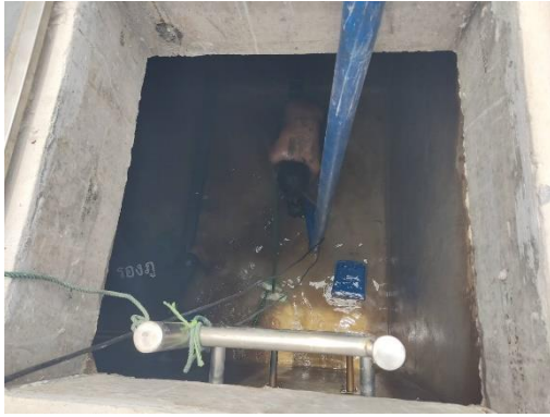
ล้างทำความสะอาดถังเก็บน้ำสำรองของโครงการ ภาพที่ 2.2-9 (ต่อ) การสำรอน้ำใช้ภายในโครงการ
